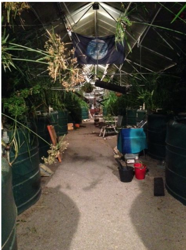
Findhornin kuuluisa Living Machine, elävä jätevedenpuhdistamo joka käsittelee koko kylän likavedet.
