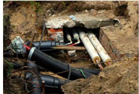
Uudet eristetyt putket (erottuvat kuvassa mustina) korvaavat vanhat putket (kuvassa valkoisina). Valokuva: Achim Ecker.
