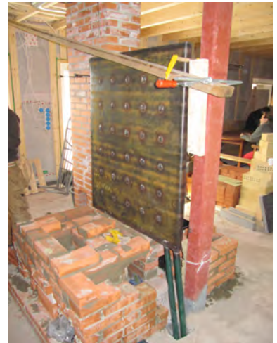
Varaavan takan muuraustyöt. Vedenlämmittinkomponentti näkyy rakennelman keskellä. Valokuva: Ella Suhonen.
