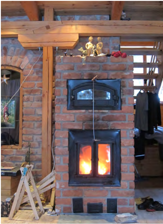
Käytetyistä tiilistä rakennettu takka. Valokuva: Mia Saloranta.
