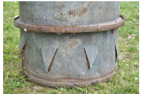
Yksityiskohta ilmanottoaukoista öljytynnyrin pohjassa. Valokuva: Jesús Pacheco Justo.
