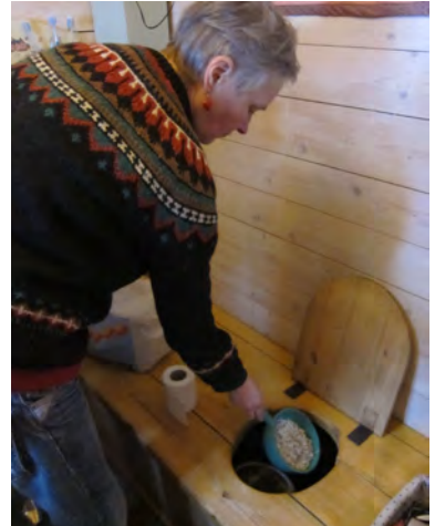
Sahajauhoa lisätään käymälään käytön jälkeen. Käymäläaukossa näkyy muovisuppilosta valmistettu virtsanerottelija. Valokuva: Mia Saloranta.
