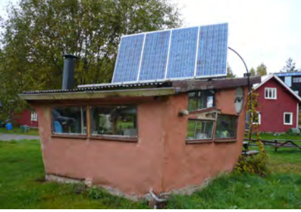
Talon katolle asennettu aurinkopaneelijärjestelmä. Valokuva: Karl Gunnar Randau.
