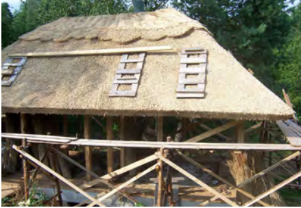
Olkitalon rakentamista. Valokuva: Domantas Surkys.
