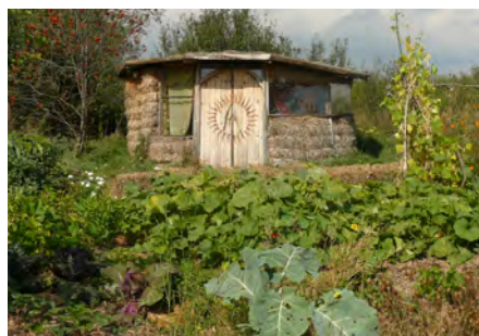
Olkipaalirakenteinen pyöreä ulkorakennus. Valokuva: Monika Podsiadła.
