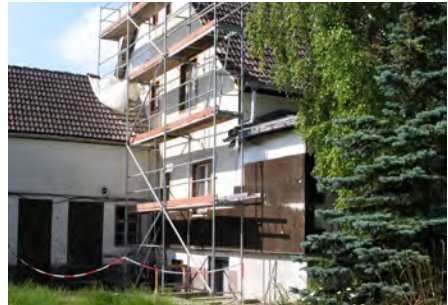
Korkkieriste ulkoseinässä. Valokuva: Achim Ecker.
