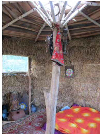
Pyöreä olkipaaliulkorakennus sisältä päin. Valokuva: Mia Saloranta.
