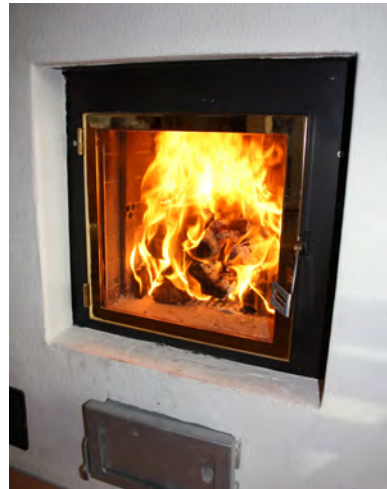
Toisioilmareivät ohjaavat toisioilmaa liekkien ylemmän kerrokseen. Valokuva: Ella Suhonen.
