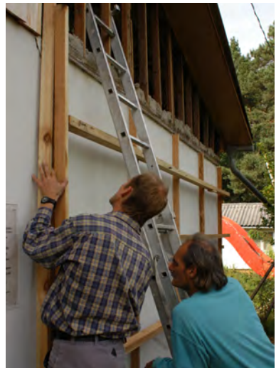
Lisäeristeen tukirakenne. Valokuva: Achim Ecker.
