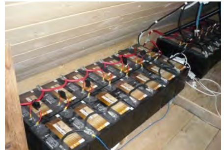
Sähkövaraamisjärjestelmä (12 voltin "akkupankki"). Valokuva: Karl Gunnar Randau.
